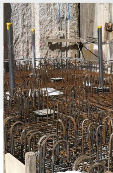
Anker-Litzen mit Schutzdeckel und Litzenabdeckung
